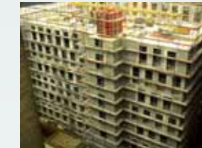
Rohbau des 2C Gebäudes
