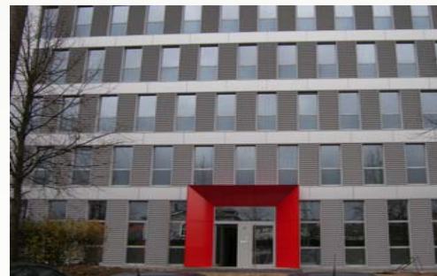
Neubau Bürohaus Baufeld 2a Gebäudeteil 2C
